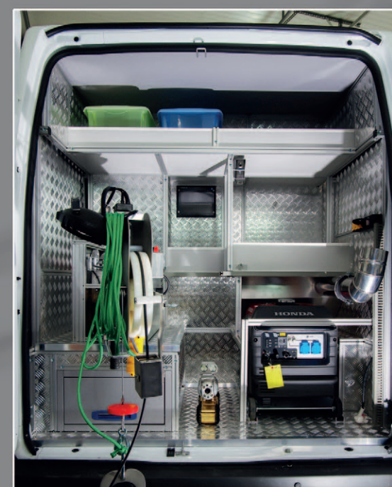
Część robocza pojazdu do inspekcji sieci TV rur – z zabudowanym systemem inspekcyjnym IGS ProfiFlex, Honda EU30is – Ford Transit
